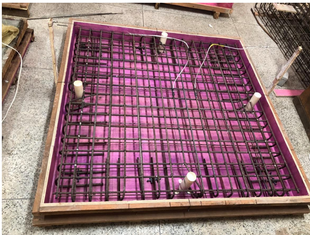
Figura 32 - Forma com as armaduras de flexão instaladas.
